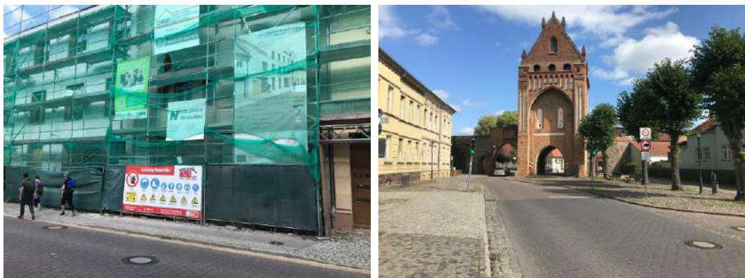
Abbildung 33: Bau des Gesundheitszentrums sowie Ruppiner Tor im historischen Stadtkern von Gransee
