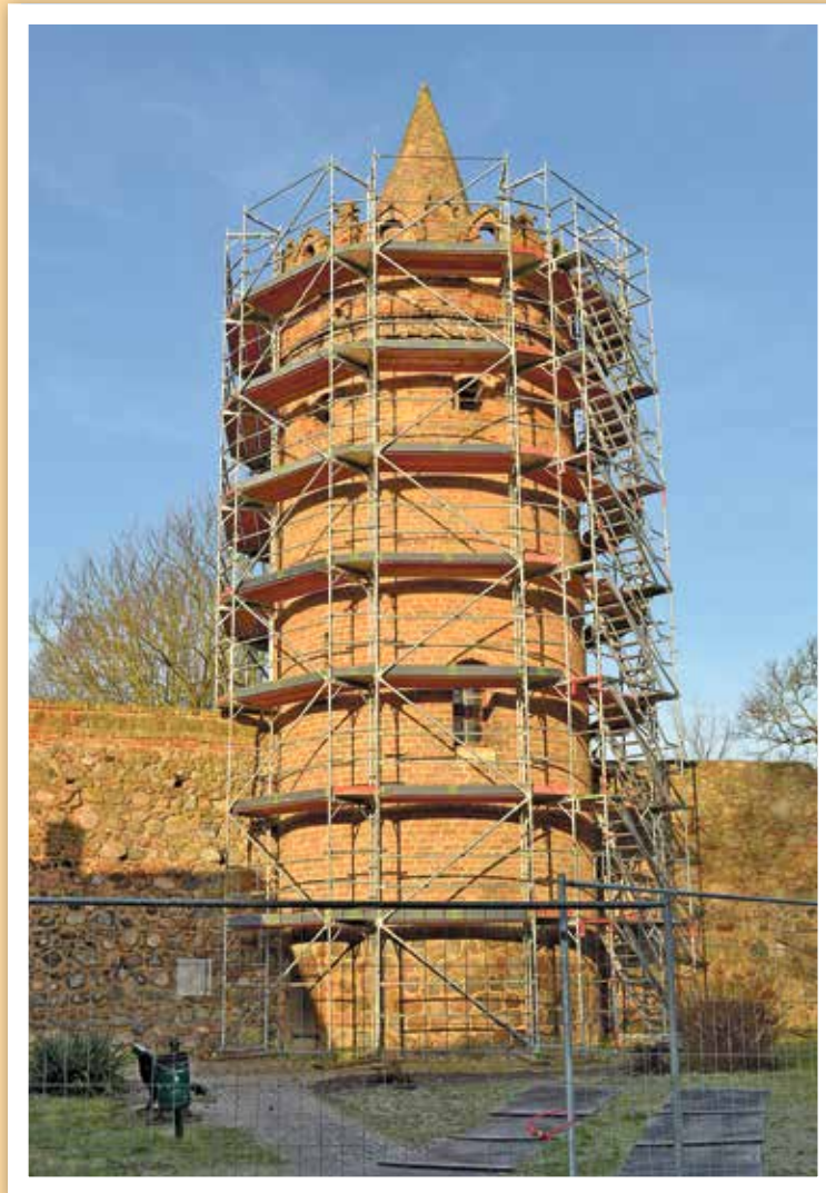
Sanierung Pulverturm schreitet voran
